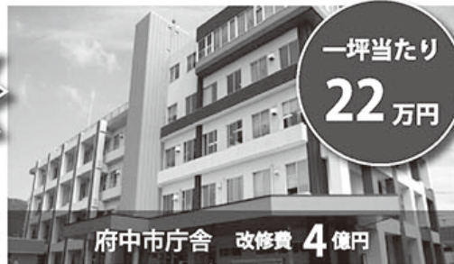
府中市庁舎(6,000㎡)Is値=0.15→0.675に耐震改修。
