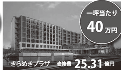
旧国立岡山病院(1960年竣工)の建物(20,816㎡)を耐震補強・全面リニューアルするという大規模コンバージョン(用途変更)を行ったもの。2008年度日本建築学会 技術部門設計競技「公共建築の再構成と更新のための計画技術」佳作を受賞。耐震改修費、機能改修費と全面的な内部改修。
