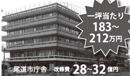
尾道市が提出の市庁舎本館(5,040㎡)の耐震改修。
